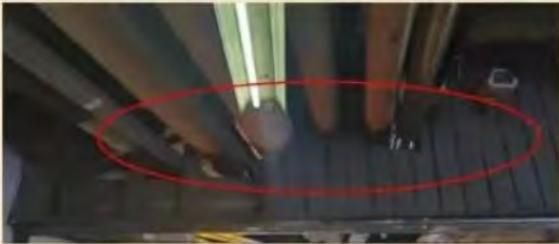
图1、管道穿过防火分区处，未进行封堵破坏分区完整性
