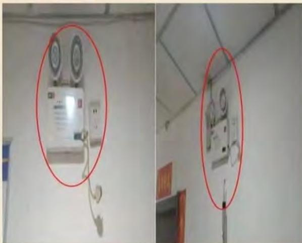
图1、2 应急照明灯在断电情况下不亮，影响正常运行
