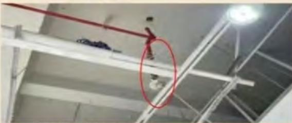
图1、不做吊顶的场所，不得悬空设置探测器
