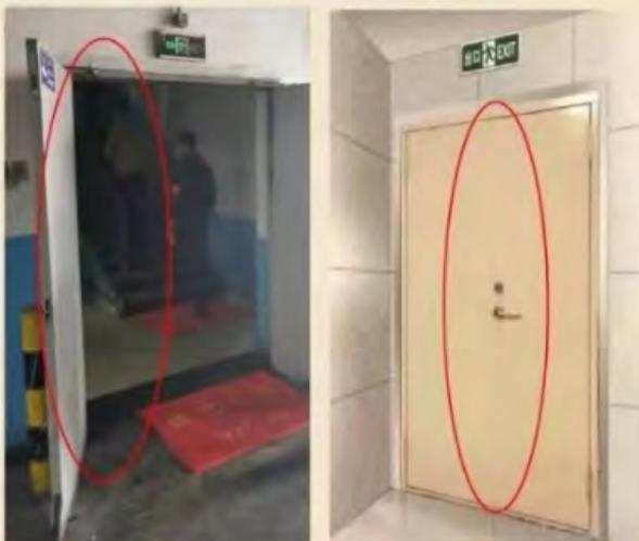
图1、2 疏散门和安全出口的门开启方向错误
