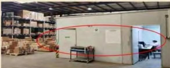
图2、仓库内采用彩钢板搭建办公室，材料燃烧性能不符合要求
