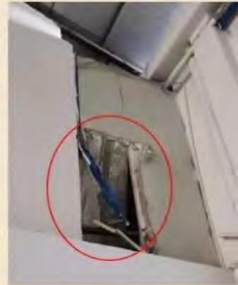
图2、建筑之间使用泡沫夹芯彩钢板搭建构筑物，作为仓库使用
