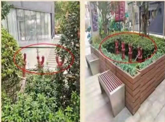
图1、2 水泵接合器被埋压、圈占影响正常使用
