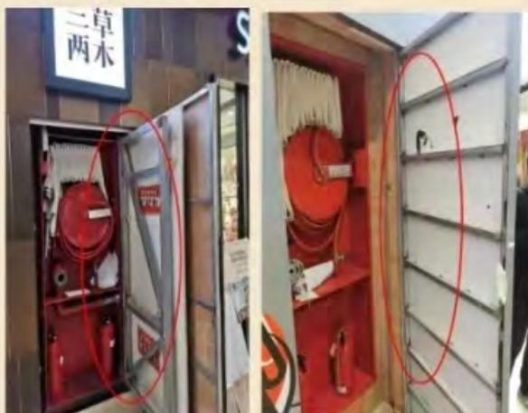
图1、室内消火栓箱门的开启角度不符合要求
