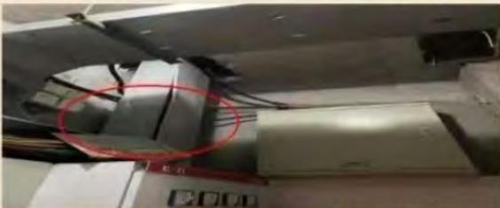
图1、电缆井穿越楼板处未进行防火封堵或封堵材料脱落
