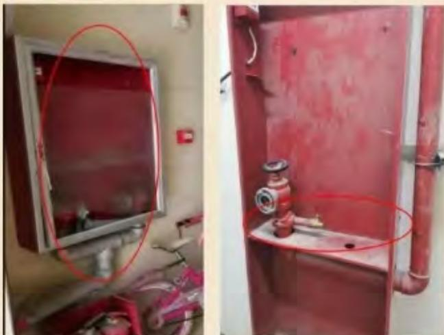
图1、2 室内消火栓内没有配置水带、水枪等配件，缺少巡检记录
