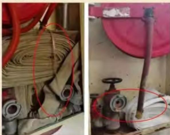
图1、2 室内消火栓栓口锈蚀，消防水带、消防卷盘损坏
