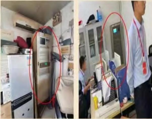
图1、消防控制室内堆放杂物 图2、消防控制柜不便于操作
