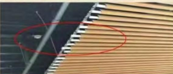
图2、设置格栅吊顶的场所，探测器位置取决于镂空面积
