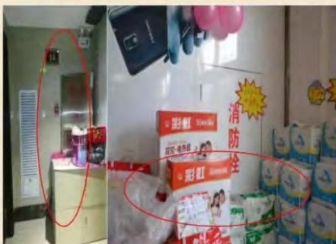
图1、2 室内消火栓前堆放货物、柜子，影响正常开启使用
