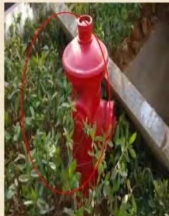
图1、2 室外消火栓被埋压、圈占，影响正常使用
