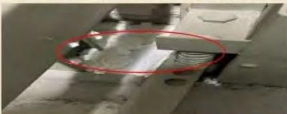
图2、管道井穿越楼板处采用可燃泡沫聚氨酯材料封堵
