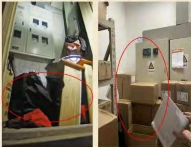
图1、2 配电房、设备间作为杂物间使用，堆放可燃材料
