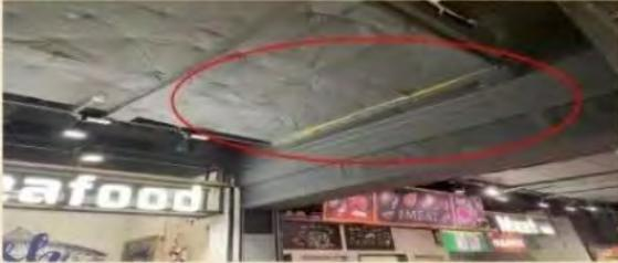
图2、排烟风管穿过防火分区处，未设置防火阀
