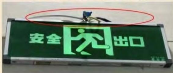
图2、灯光型疏散指示标志灯的线路未穿管保护
