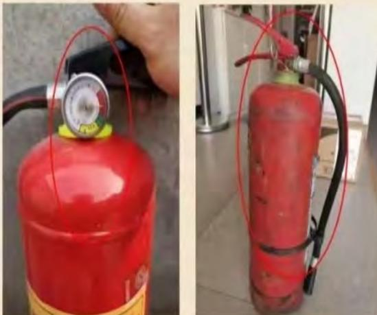
图1、灭火器压力指示不正常 图2、灭火器筒体锈蚀、破损
