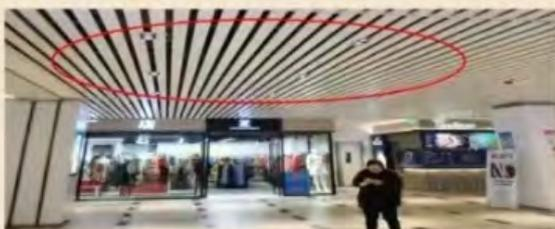
图1、网格、栅板类吊顶布置喷头位置错误
