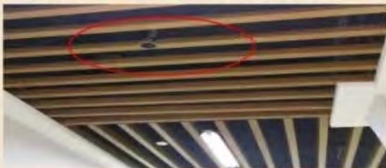
图2、网格、栅板类吊顶布置隐蔽式喷头，选型错误
