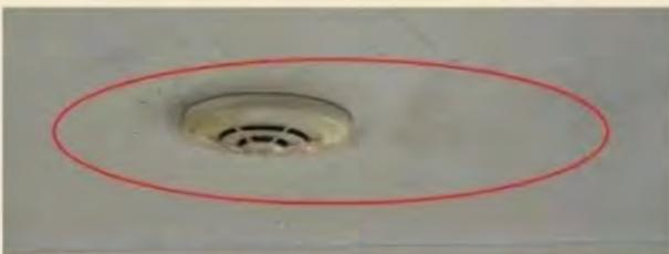
图3、厨房内报警探测器油垢严重，探测器不能正常报警
