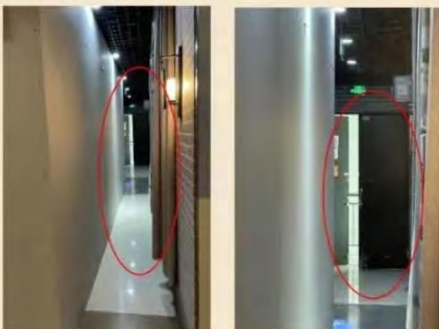
图1、2 商铺装修占用建筑内主要疏散走道，影响疏散宽度
