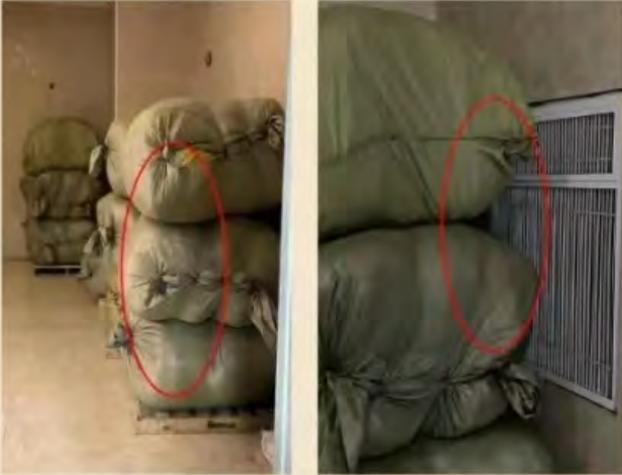
图1、前室内堆放杂物遮挡消防栓 图2、前室内堆放杂物遮挡正压送风口
