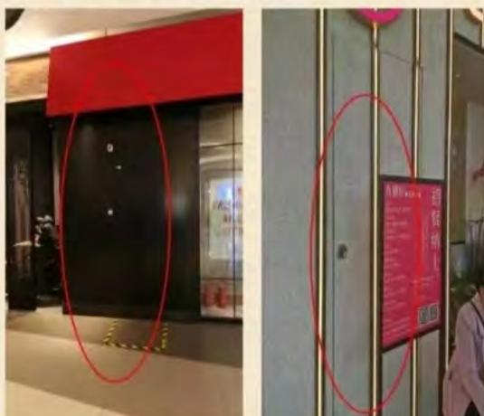
图1、2 室内消火栓箱标识不明显、没有明显区分
