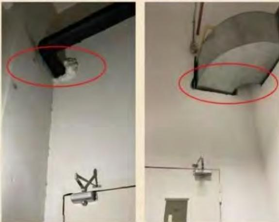
图1、管道穿过疏散楼梯间隔墙处，采用聚氨酯可燃材料封堵
