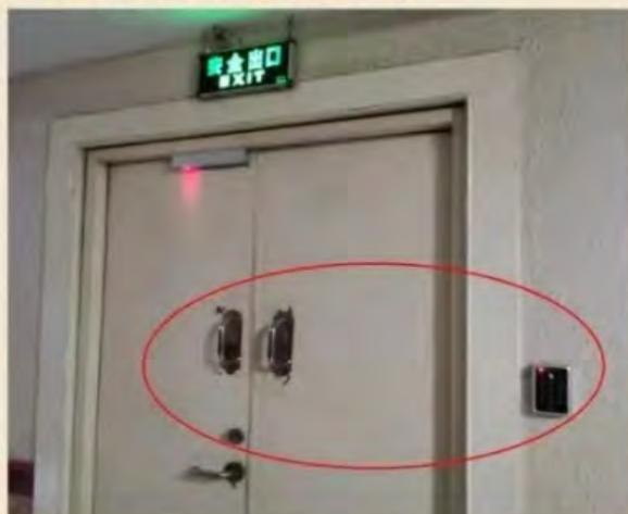
图1、安全出口的门设置用密码或者磁卡开启的门禁系统
