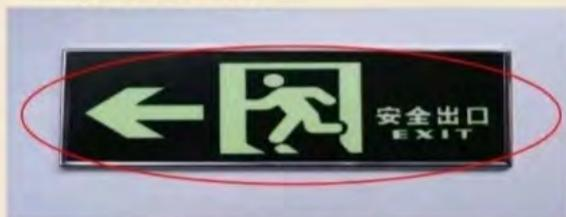
图1、蓄光型疏散指示标志，直接贴于前面
