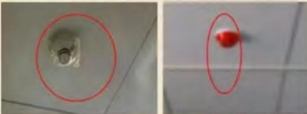
图1、厨房内报警探测器被包裹 图2、探测器防尘罩未摘除
