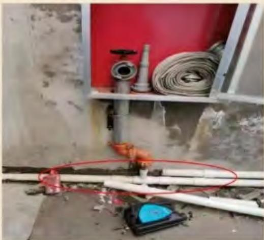
图1、消火栓箱的供水管道材质不符合要求
